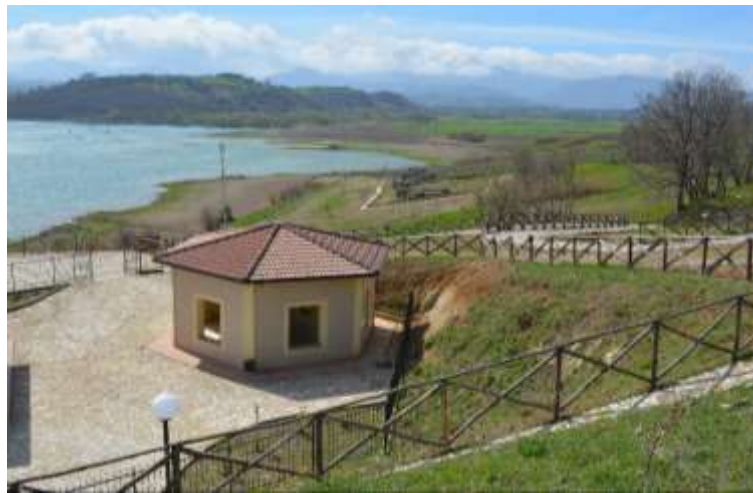
Villa romana di Larderia: veduta da sud-est
