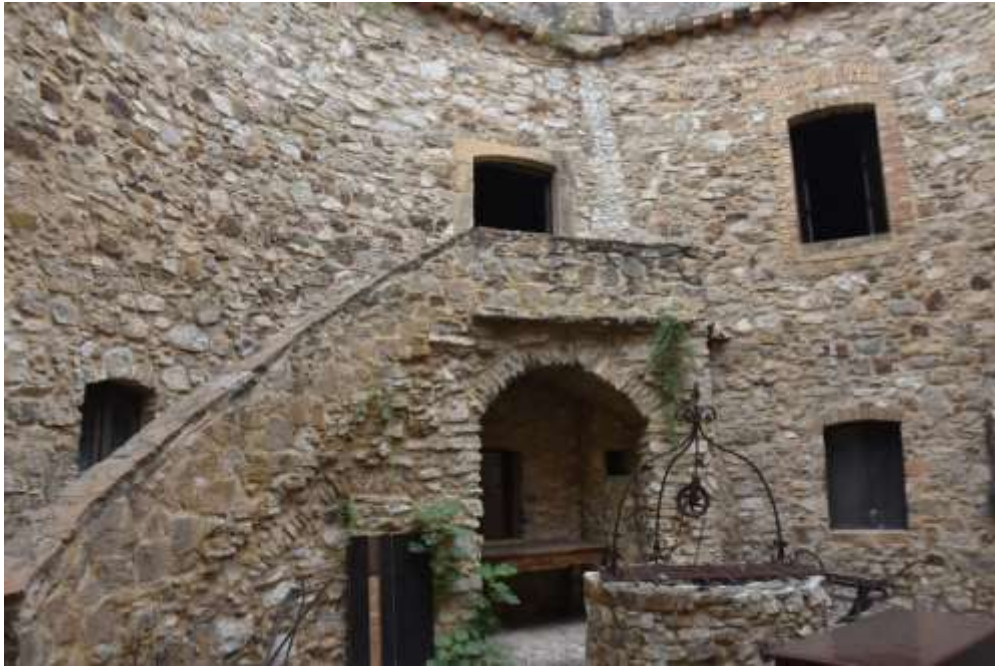
Interno della torre
