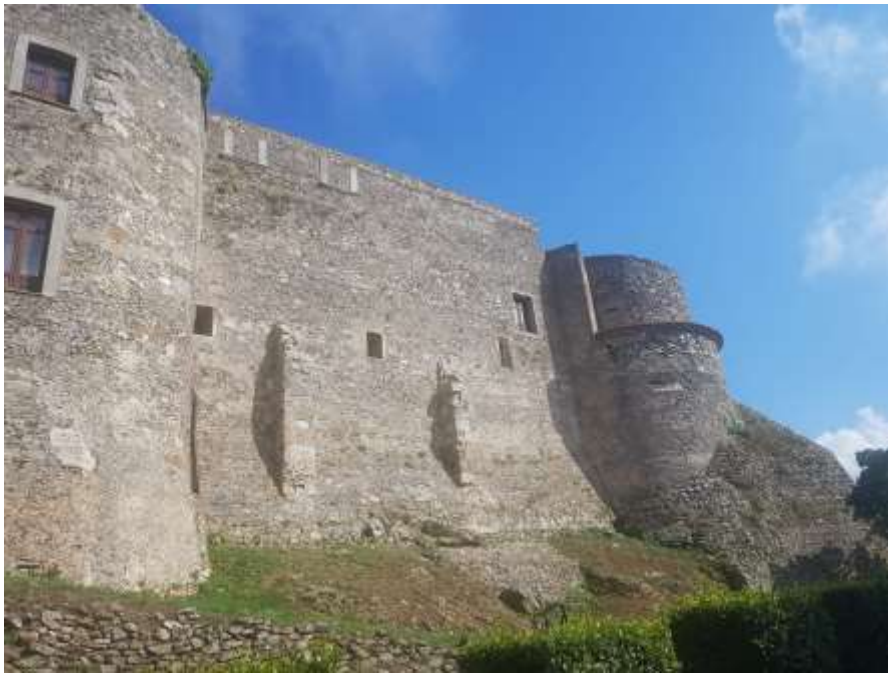
Prospetto castello lato nord
