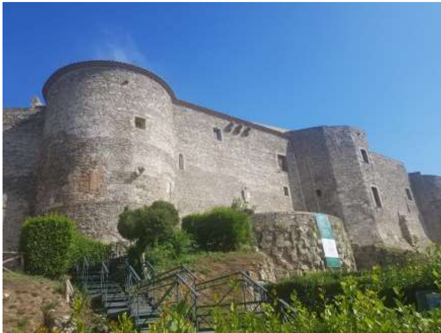
Prospetto ovest del castello
