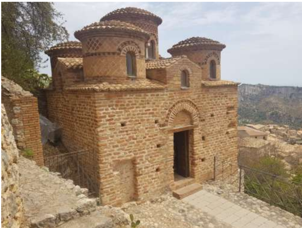
Cattolica di Stilo: veduta laterale da monte
